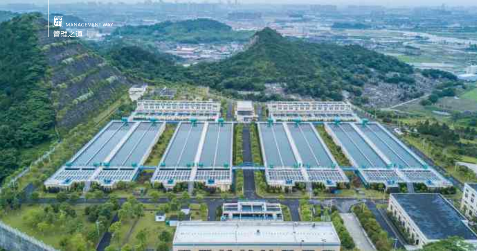
东钱湖水厂航拍
