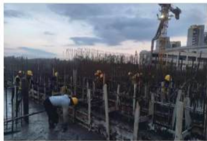
5月5日凌晨,宁波工业供水公司姚江水厂20万吨/天扩建项目工地,一派热火朝天的忙碌景象。工人们正在完成该项目最大板块——V型滤池底板及管廊间平台与地下一层的浇筑。
