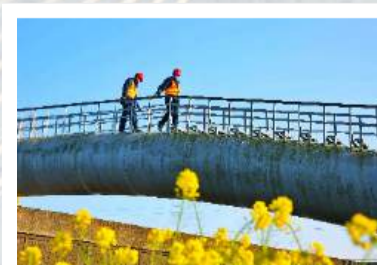
▲ 严峻的疫情下供水大动脉巡检不能误-张良
