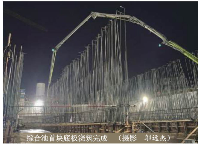
综合池首块底板浇筑完成（摄影 郭远杰）
